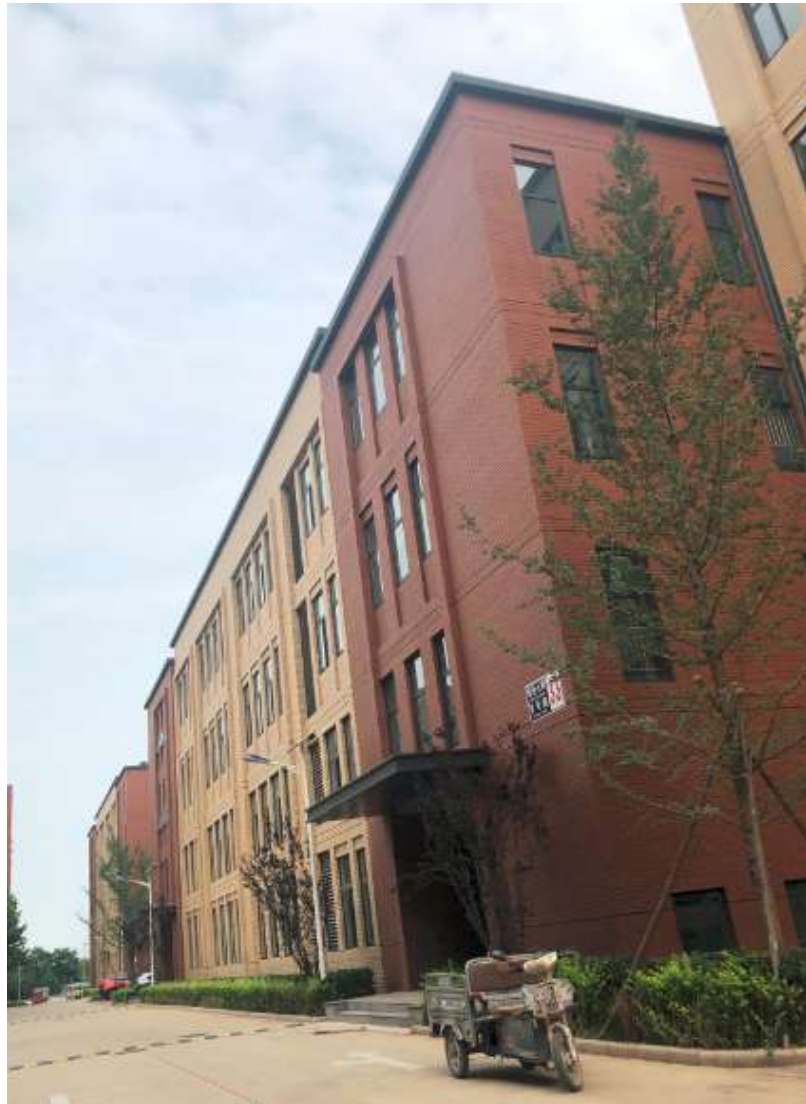
图 1-6 本项目所在建筑现状照片
