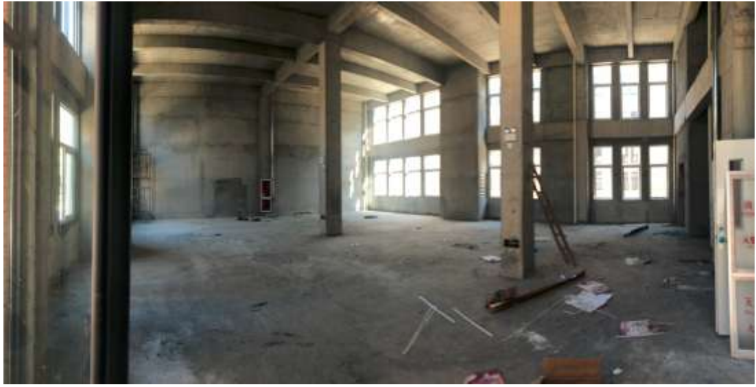
图 1-5 本项目所在建筑内现状照片（2 层区域）
