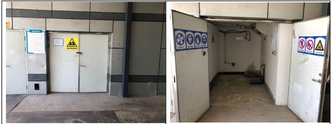
图 10 现有危废暂存间
