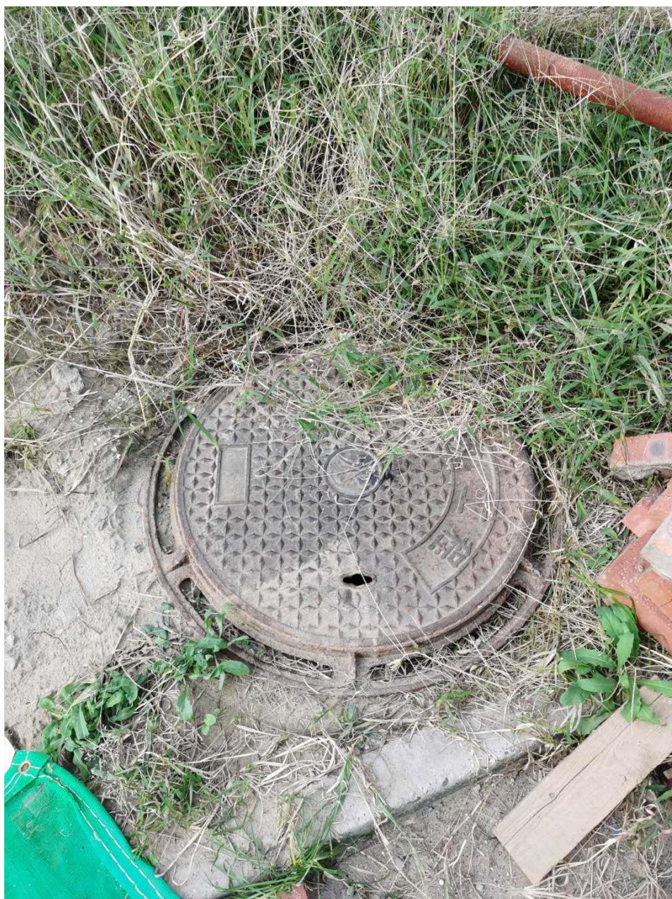
图 11 废水总排口现状情况
