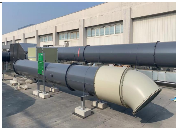
废气处理装置及排口（DA026）
