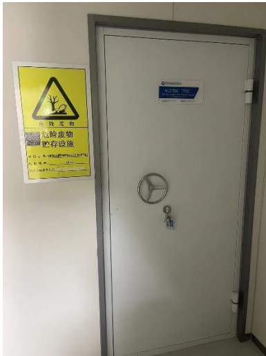
危废暂存间外部（三层）
