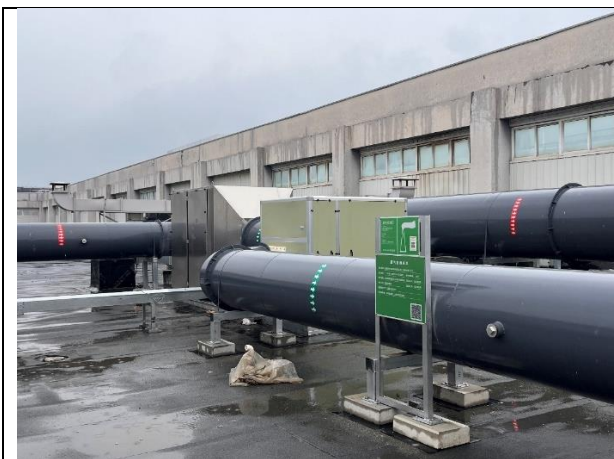
废气处理装置及排口（DA026）
